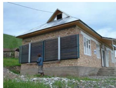
Рис. 2. Местная больница, оборудованная солнечными коллекторами
