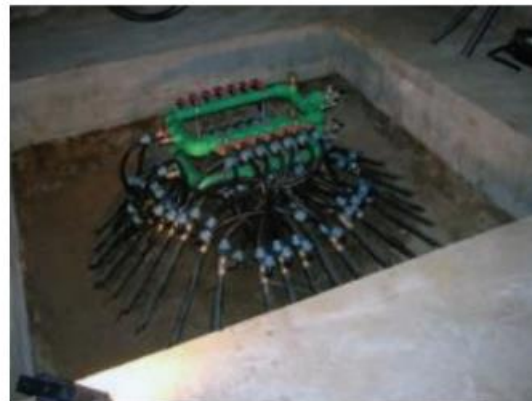
Рисунок 4 – Монтаж установки кластерного геопоя
