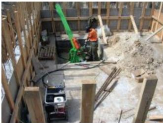
Рисунок 4 – Монтаж установки кластерного геопоя
