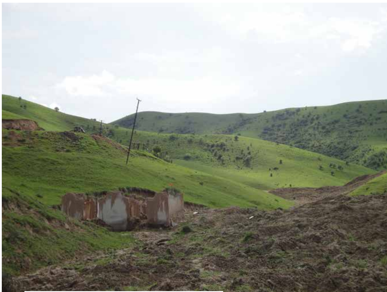
Дом уничтожен оползнем в Джалал-Абадской области
